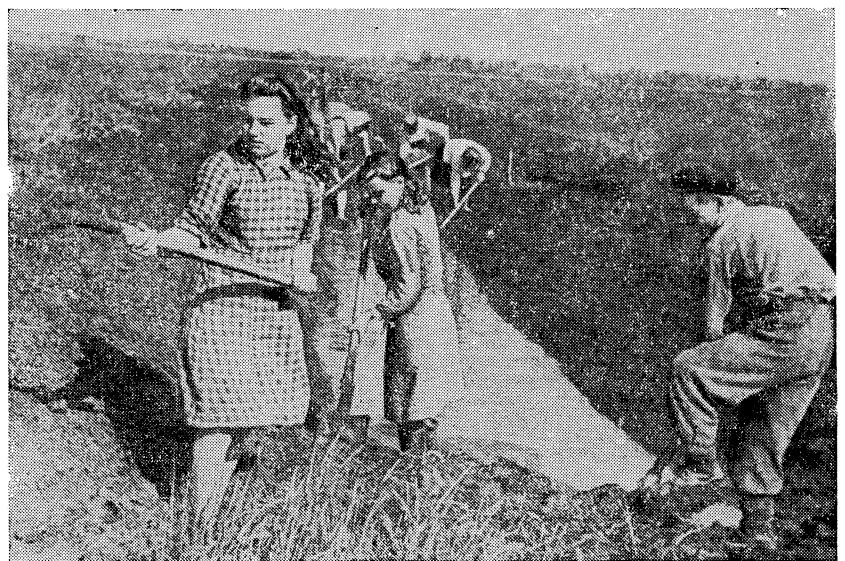
Народная стройка в пойме реки Яхромы. Очистка магистральной канавы.
